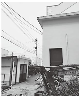
倉庫の全部とトイレは一部を除いて解体撤去された
