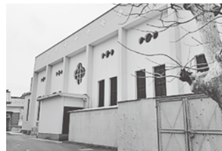
聖堂横に仮設の倉庫を設置した
