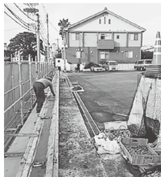
敷地外周塀改修工事の様子
