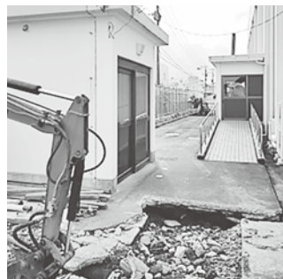
写真左のトイレを男性用に改修し、重機のある位置に女性トイレと多目的トイレを増築します
